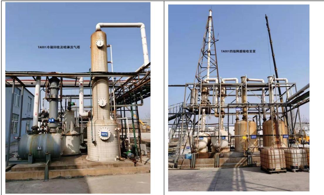
2、原料仓库、危废间废气：经过 TA002（喷淋吸收塔）处理后，通过 DA002 排气筒排放。
