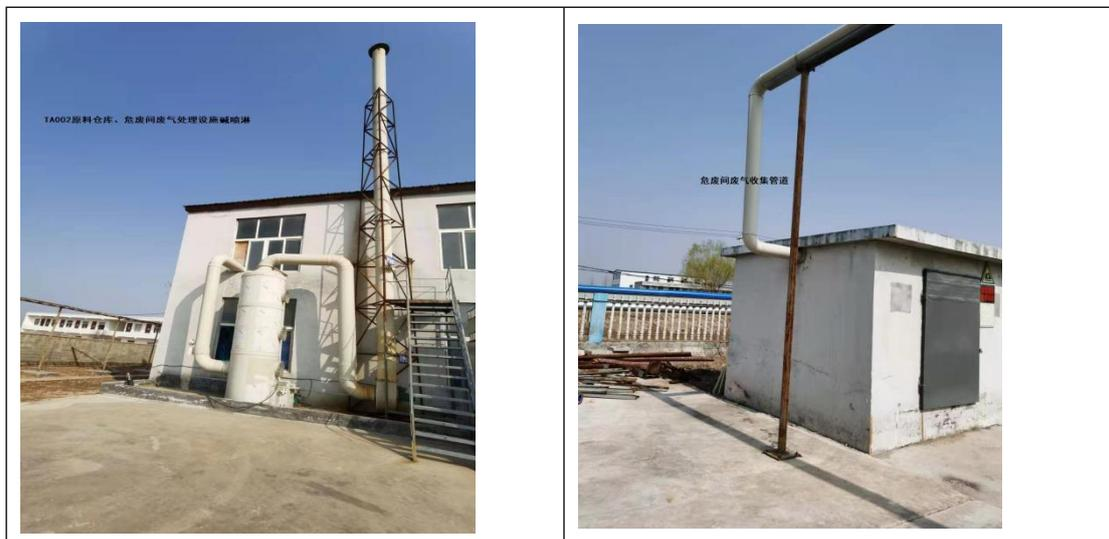
3、成品仓库及污水站废气：经过 TA003（喷淋吸收塔）处理后，通过 DA003 排气筒排放。
